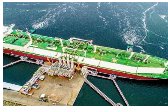
Figure 10: LNG regasification terminal
